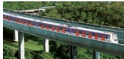
高架路上的西鐵列車。 West Rail train on viaduct.
