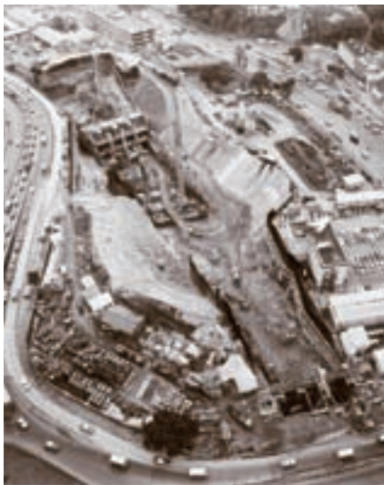
興建中的金鐘站，攝於1978年2月。 Construction of Admiralty Station in Feb 1978.
