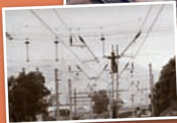
電氣化工程。 Electrification works.
