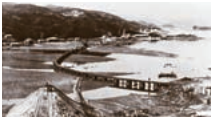
大埔滘以南的建造工程。 Construction works south of Tai Po Kau.
