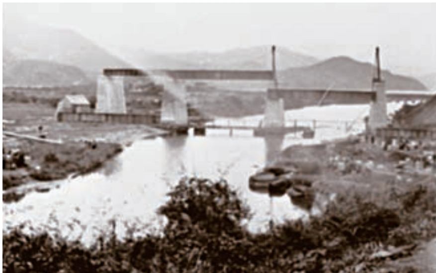
建造鋼樑大橋。 Construction of steel girder bridge.
