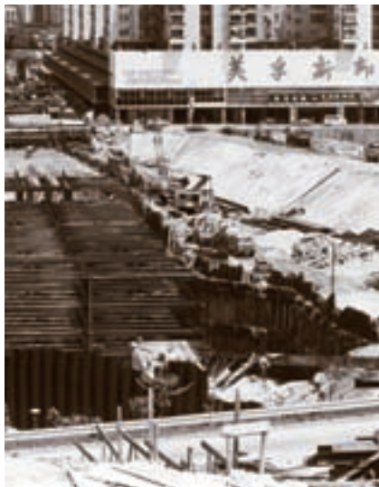
興建中的美孚站，攝於1980年8月。 Construction of Mei Foo Station in Aug 1980.
