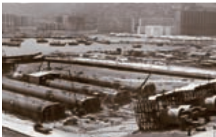
1977年興建中的地鐵海底隧道路段，照片攝於此等路段未被拖出海面及下沉至適當位置前。
