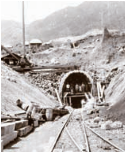
1909年興建中的筆架山隧道。 Beacon Hill Tunnel under construction in 1909.
