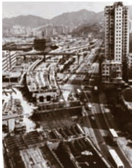
興建中的九龍灣站，攝於1978年5月。 Construction of Kowloon Bay Station in May 1978.
